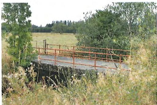
La passerelle après le pertuis
