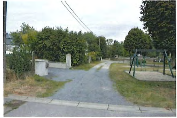
Chemin de desserte de l'arrière des maisons de la Rue de la Gare (N83)
