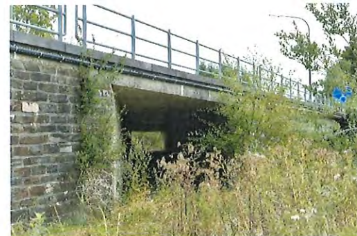
Le tunnel sous voie
