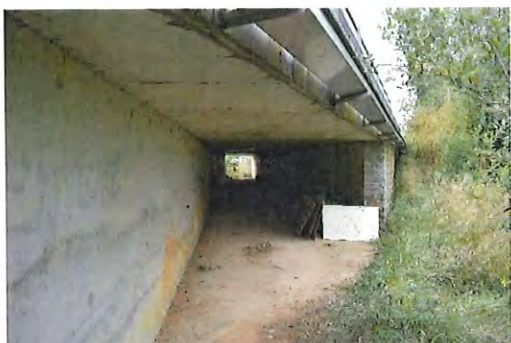
Le tunnel sous voie
